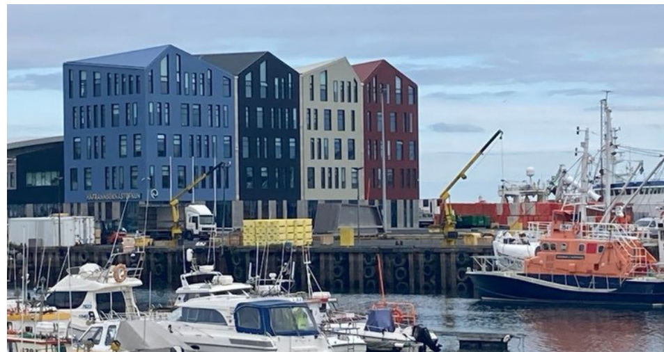
Höfuðstöðvar Hafrannsóknarstofnunar í Hafnarfirði. Stærsta timburbygging á Íslandi; fimm hæða timburhús byggt úr CLT-einingum frá Austurríki, vígt 2020.
